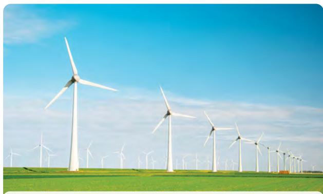
Turbine eoliene onshore (pe uscat)
